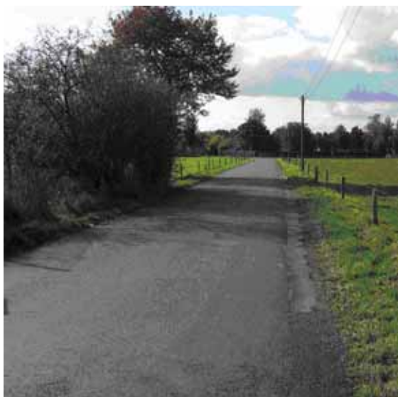
Blick auf die Baustraße im Außenbereich
