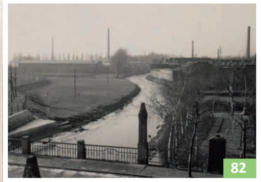
Die Westend-Brücke stadtauswärts mit dem Eingang zur Alten Aa Anfang der 1930er Jahre.
