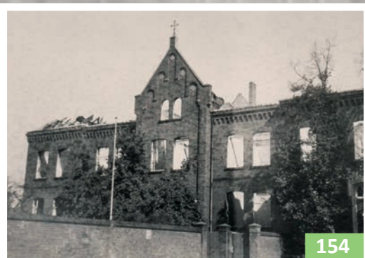
Auch das Krankenhaus an der Weberstraße/Schönenberg ist ausgebrannt.
