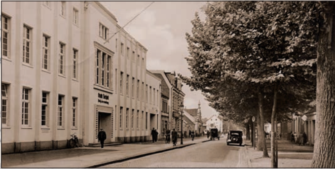
In einem vormaligen Verwaltungsgebäude an der Münsterstraße richten die Nazis die NSDAP-Kreisleitung ein. Auch das Terror-Organ Geheime Staatspolizei (Gestapo) bezieht das „Hermann-Göring-Haus“.
