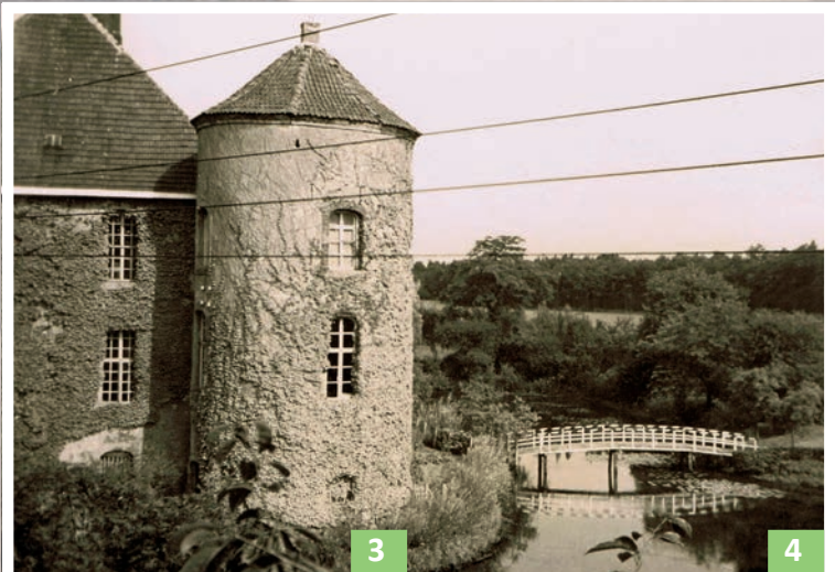
Jahrhunderte überdauert – Der mächtige Turm.
