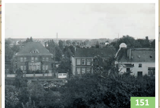
6 Villen am Südwall.
