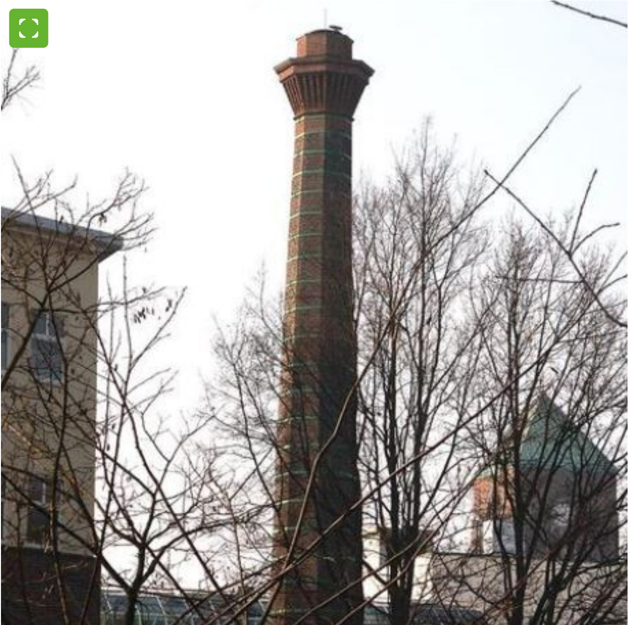
Historischer Mauerwerksschornstein in Bocholt
