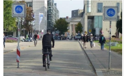
Abbildung 15: Optische Durchfahrtsperre an einer Fahrradstraße (Karlsruhe)
