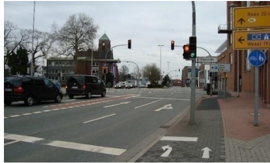
Abbildung 17: Radfahrschleuse am Knotenpunkt
